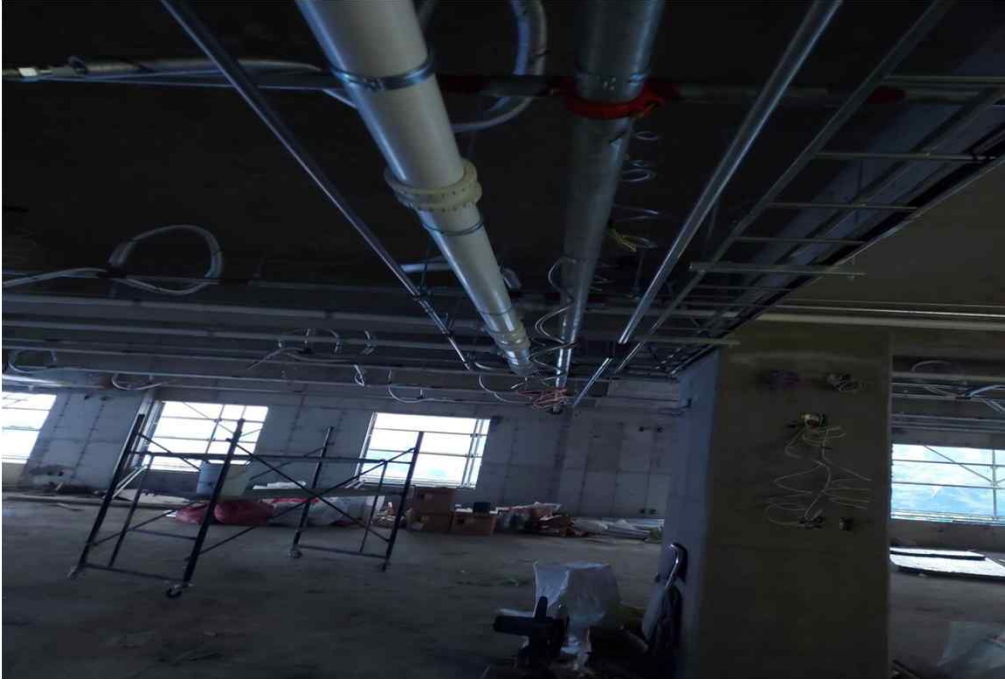
각 층 우수 및 소화 배관 공사
