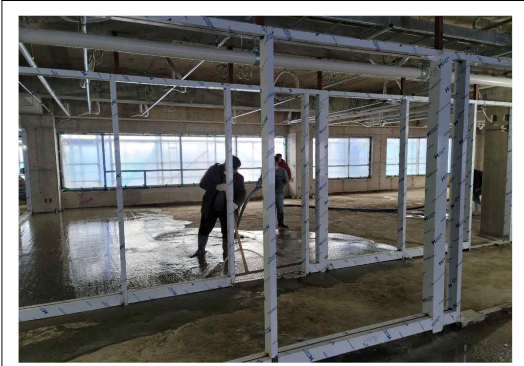
각 층 바닥 미장 작업
